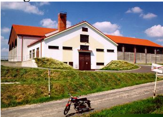
Biomasseheizwerk Staré Město
